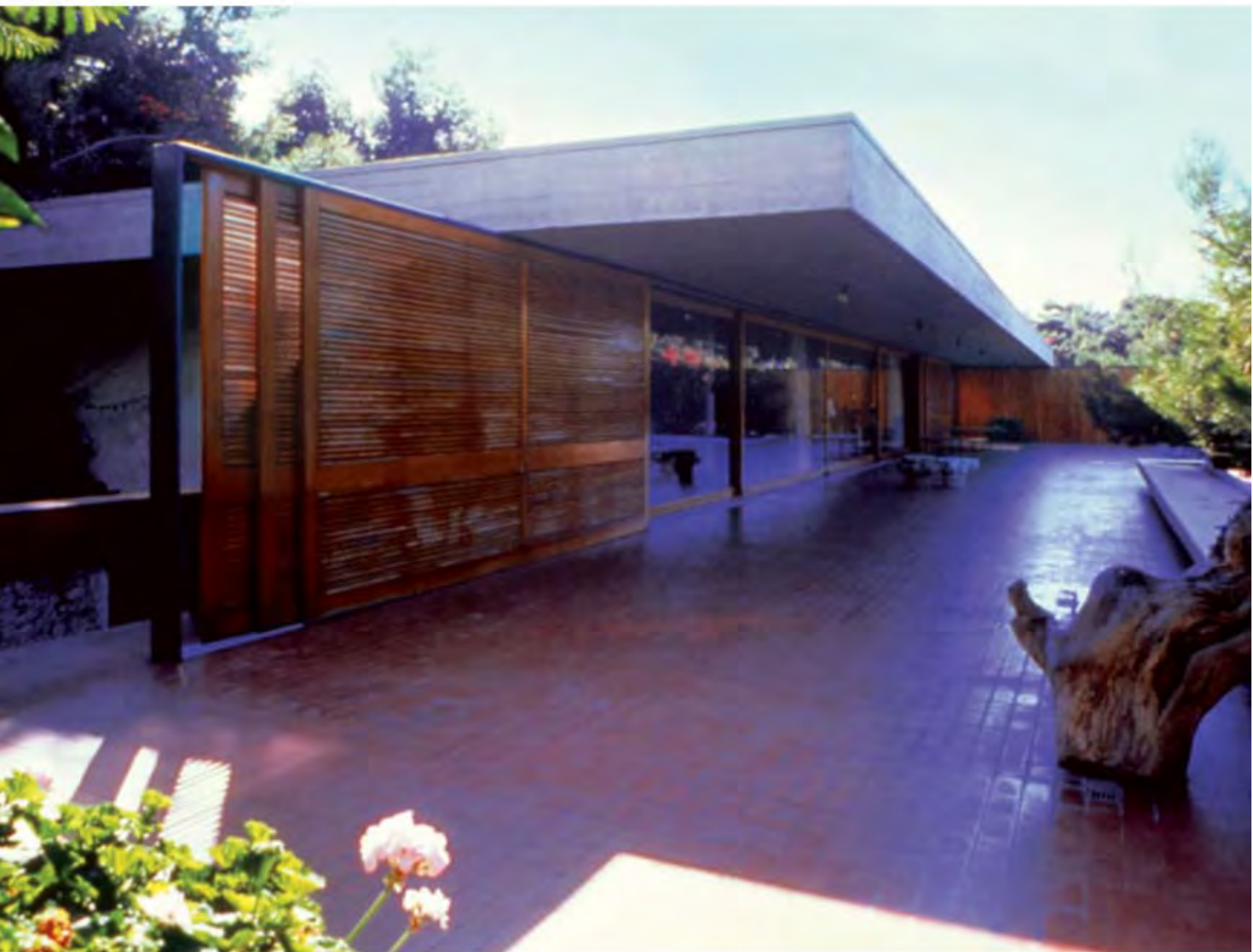
23_Κατοικία στο Καβούρι_Κωνσταντίνος Δεκαβάλλας_1971
